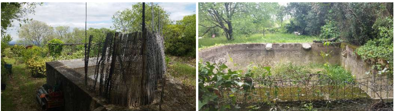
Bassins de stockage des eaux au droit de jardin potager et d'agrément
