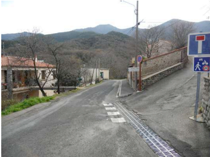
Intersection de la rue St Christophe
