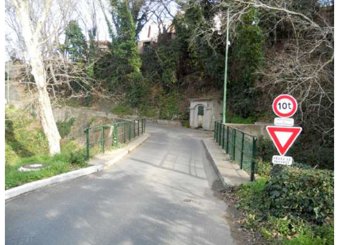
Passage vu en direction du village
