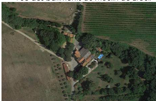
Vue des bâtiments du Moulin de Breuil
