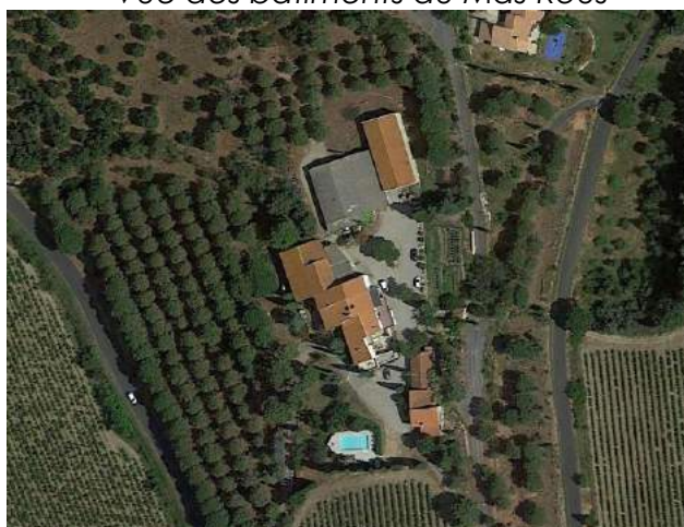
Vue des bâtiments du Mas Rous
