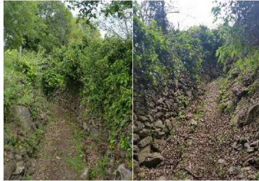
Muret de pierres sèches en limite parcellaire
