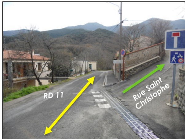
Le croisement de la RD 11 et de la Rue Saint Christophe présente une largeur réduite et un fort dénivelé.
