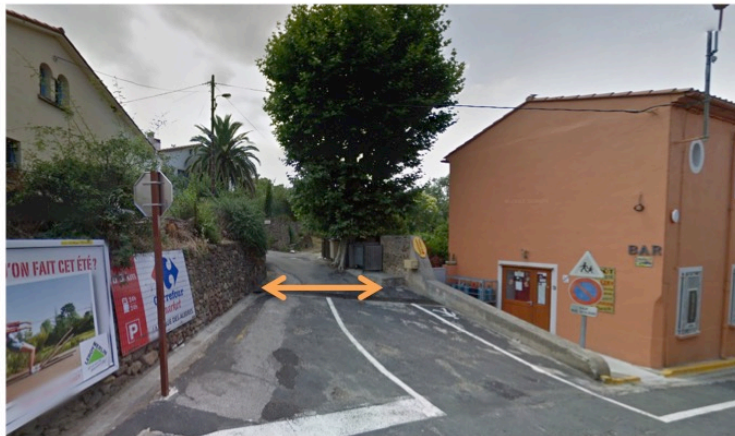
En l'état actuel, l'accès au secteur présente une largeur réduite ne permettant pas le croisement de véhicules.
