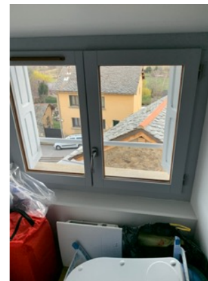
2. Après travaux: reprise des fondations, réfection de la toiture, isolation de la toiture et du plancher bas, réfection complète de l'électricité, de la plomberie, réfection de la salle de bain, pose d'un poêle à bois, mise en place de menuiseries double-vitrage bois, pose de garde-corps pour assurer les normes de décence.
